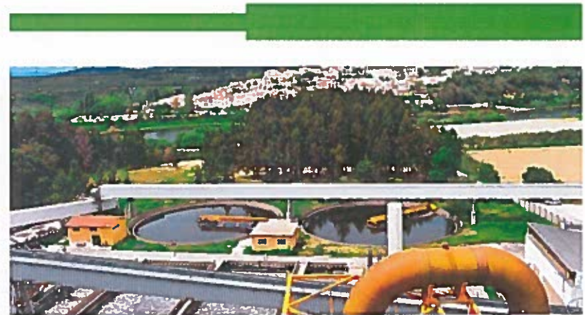
Figura 3: Estação de Tratamento de Águas Residuais Tratamento aeróbio
